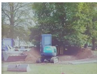
Travaux de terrassement pour Vallée
